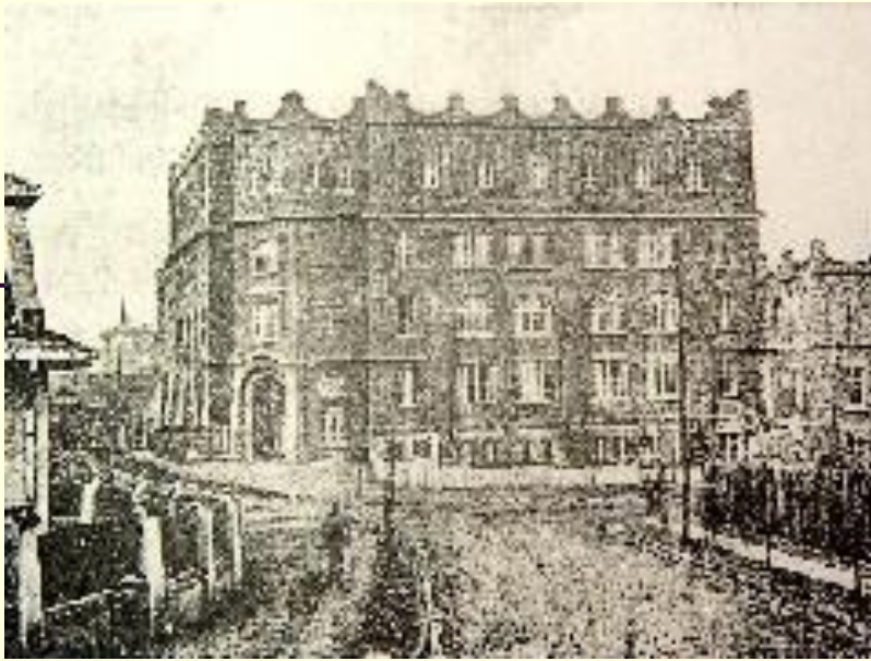
Budynek szkoły, zdjęcie z około 1924 roku.
